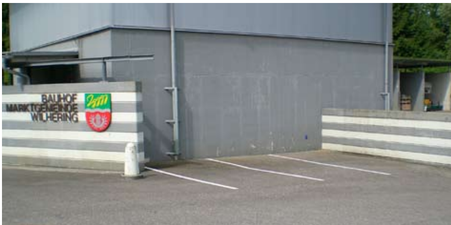
neue Parkplätze beim Bauhof
